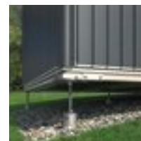
Höhenausgleich mit Erdschrauben
