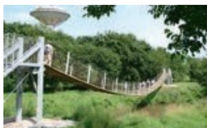
Passerelle à lattes de bois et garde-corps câble Hercule, longueur 54 m
